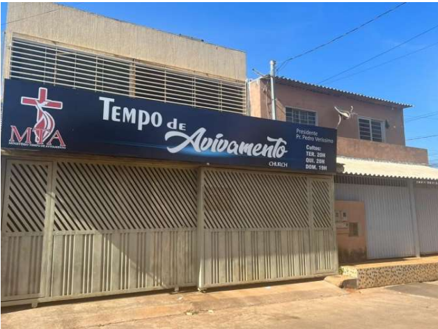
Figura 16 – Confrontação Sul - Visão da construção usada pela Igreja Tempo de Avivamento.
