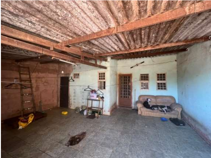
Figura 05 – Interior da garagem.
