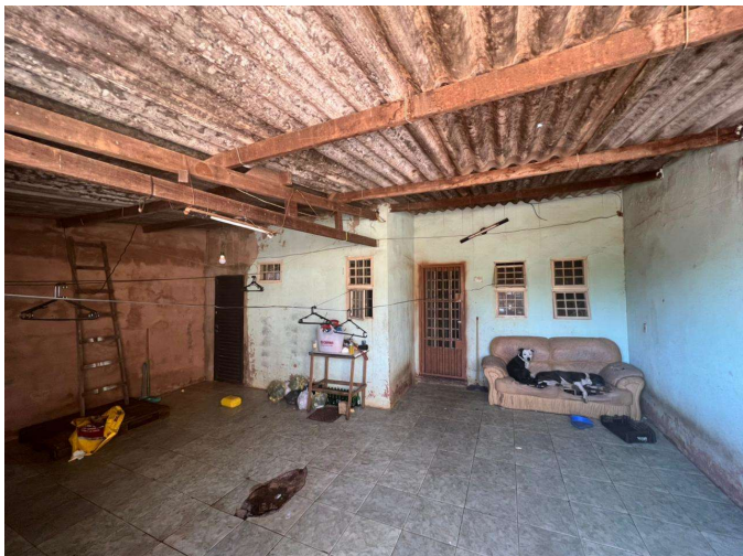
Figura 14 – visão geral da garagem.
