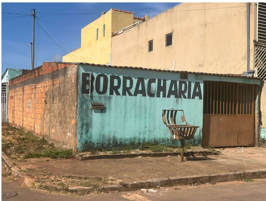
Vista do Imóvel Avaliando (Fotografia recente, de 11jun. 2022)
