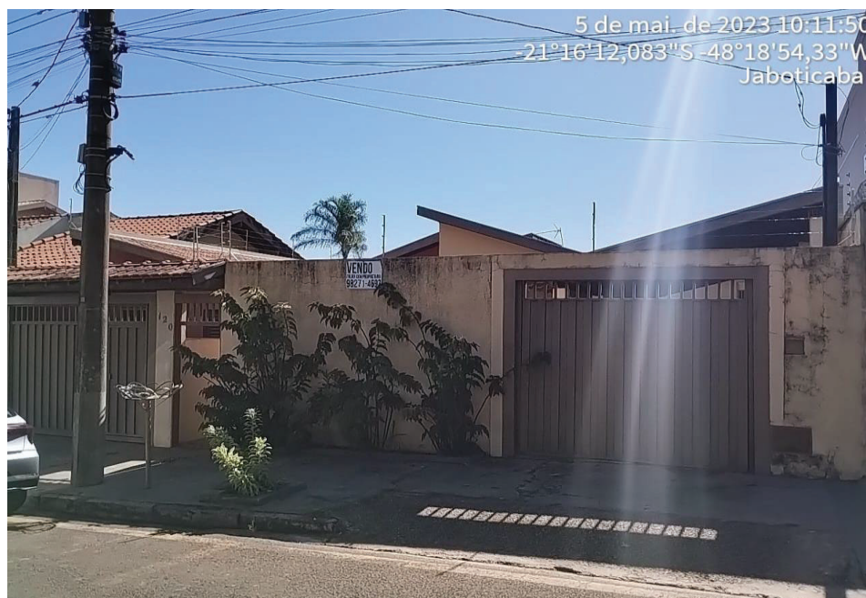
Figura 2 Vista do imóvel avaliando
