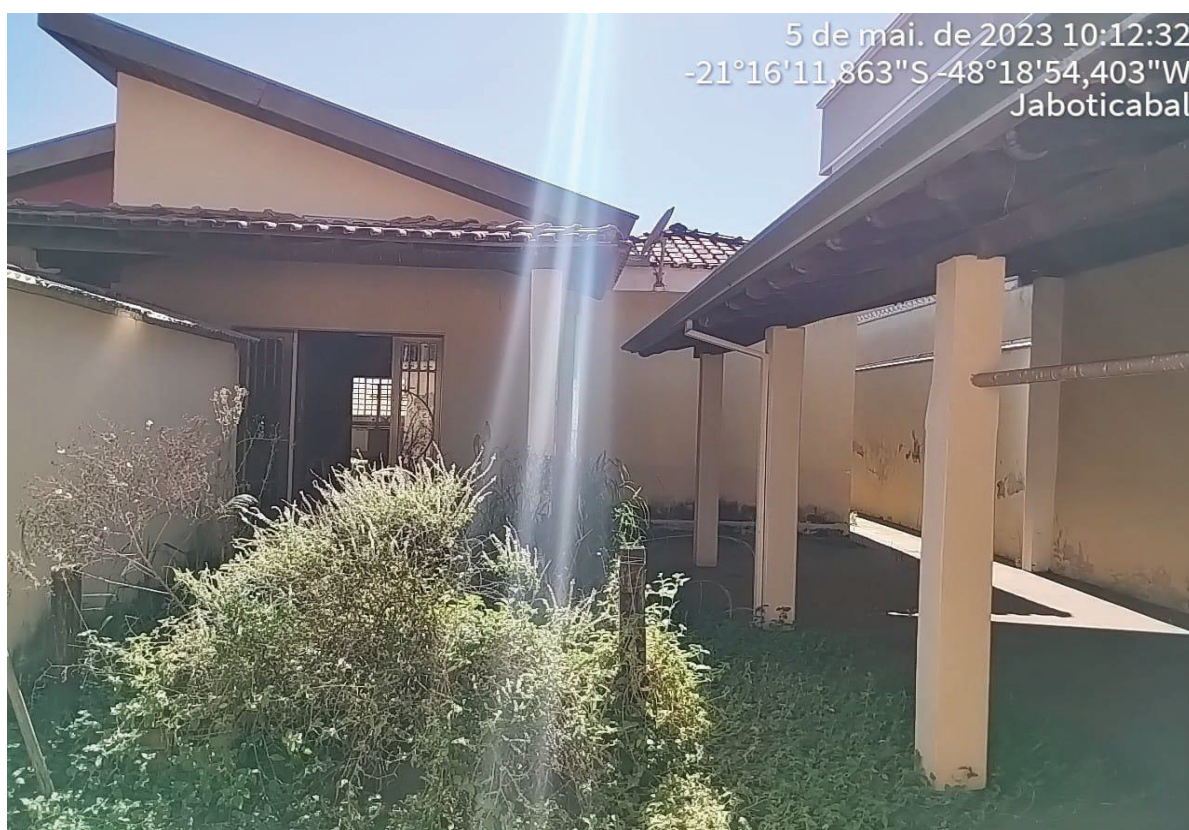
Figura 3 Fachada secundária do imóvel
