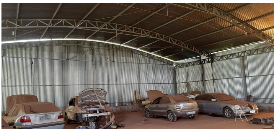
Foto nº 29- detalhe interno do hangar nº 2
