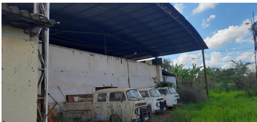
Foto nº 26- vista dos fundos do barracão do museu.
