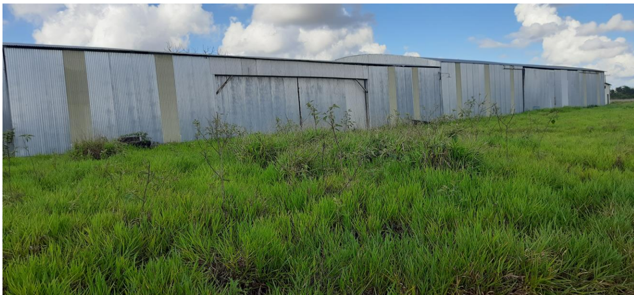
Foto nº 28- Sequencia Hangar 2 e Hangar 1
