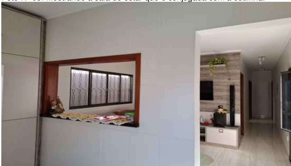
Foto N° 04: Foto tirada da cozinha que é conjugada com a sala de estar aos fundos, onde se observa a boqueta a esquerda e o espaço de passagem entre ambas.
