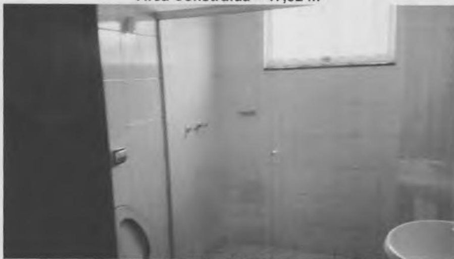
BANHEIRO 2 Área Construída – 4,81 m²
