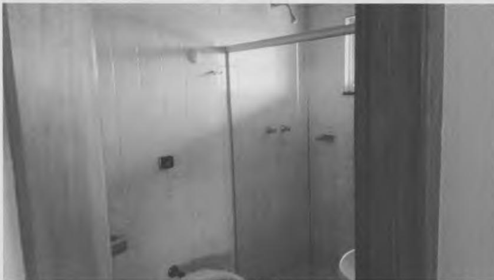
BANHEIRO 3 Área Construída – 4,81 m²
