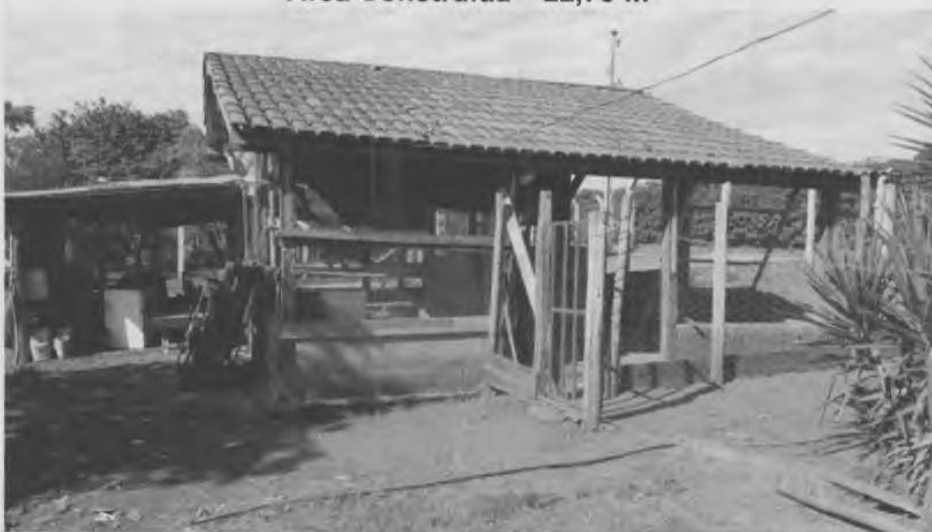
GALINHEIRO Área Construída – 57,45 m
