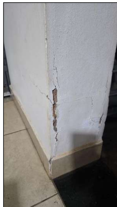
Imagem 30: Problemas encontrados no imóvel: ponto de umidade, trincas e fissuras e deterioração da pintura e forro de madeira com infiltrações.
