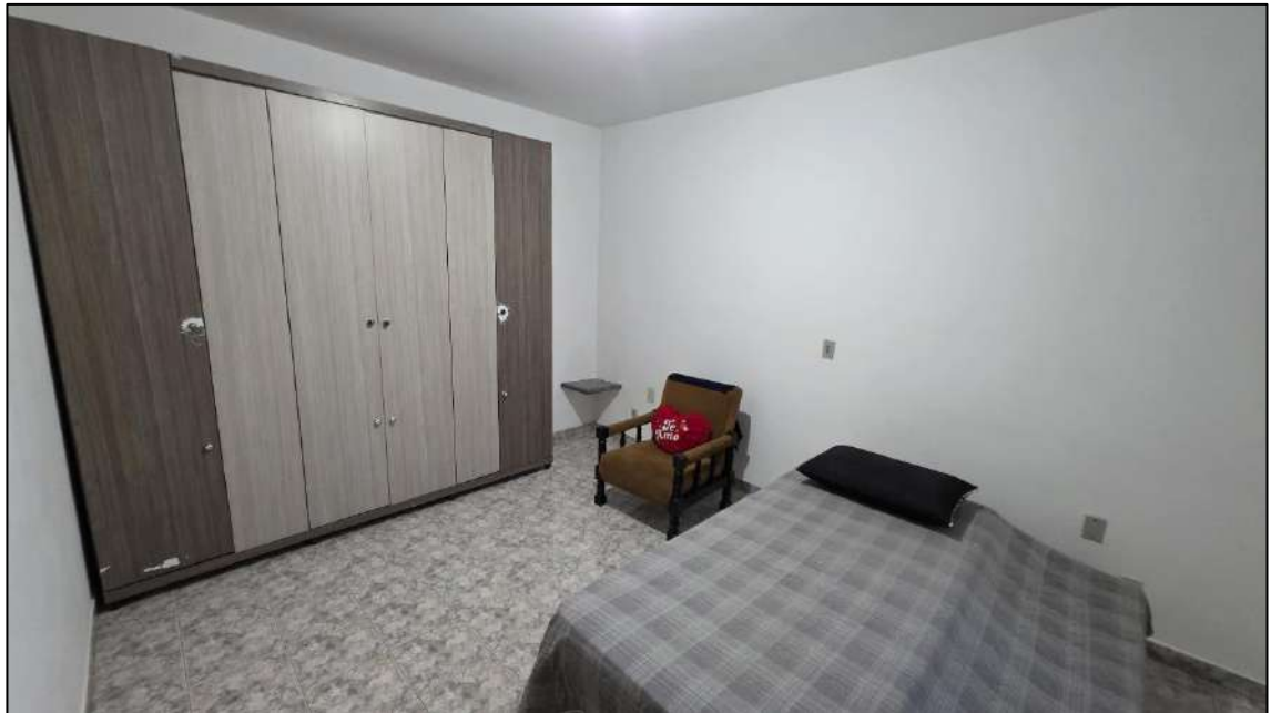
Imagem 23: Quarto 01 com piso revestido com cerâmica, paredes e laje com reboco e pintura.
