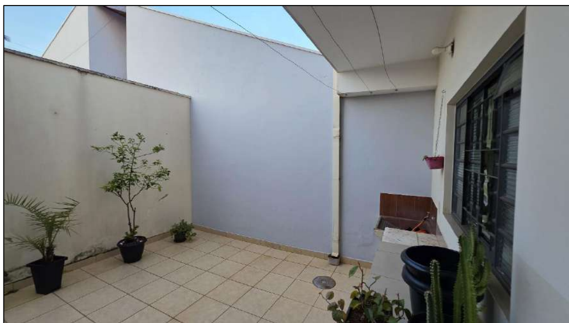
Imagem 28: Área de serviço do imóvel com piso cerâmico, parede com reboco e pintura e cobertura parcial em laje com reboco e pintura.
