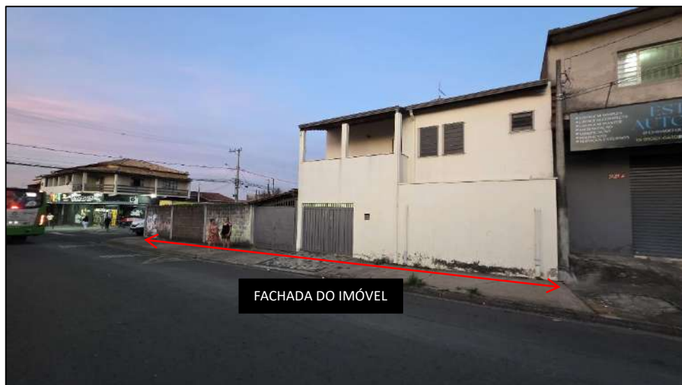
Imagem 09: Fachadas do imóvel voltadas para as Ruas Manoel Vítor Diniz e Mario Paijão.
