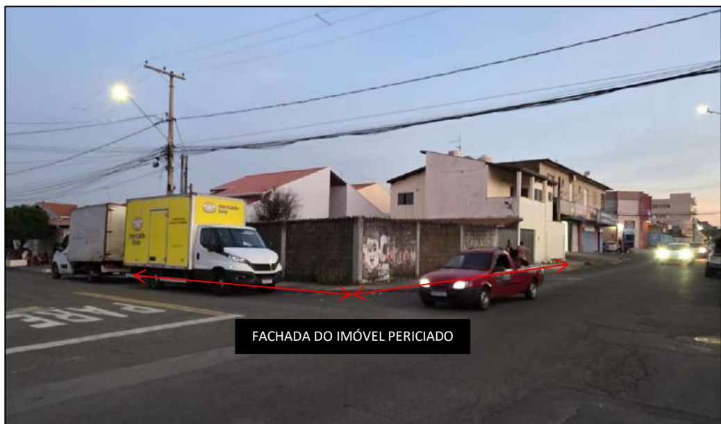
Vista para a fachada do imóvel periciado.
