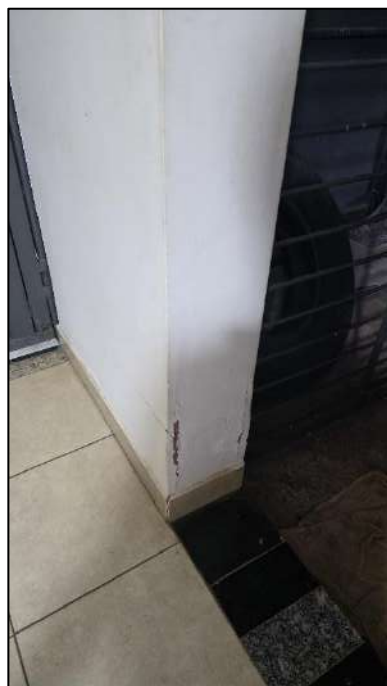
Imagem 30: Problemas encontrados no imóvel: ponto de umidade, trincas e fissuras e deterioração da pintura e forro de madeira com infiltrações.
