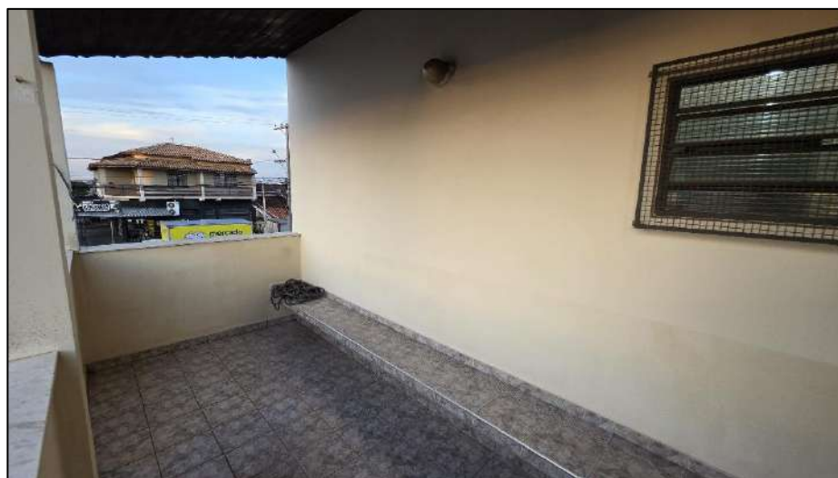
Imagem 26: Varanda do imóvel com piso revestido em cerâmica, paredes com reboco e pintura e telhado cerâmico.
