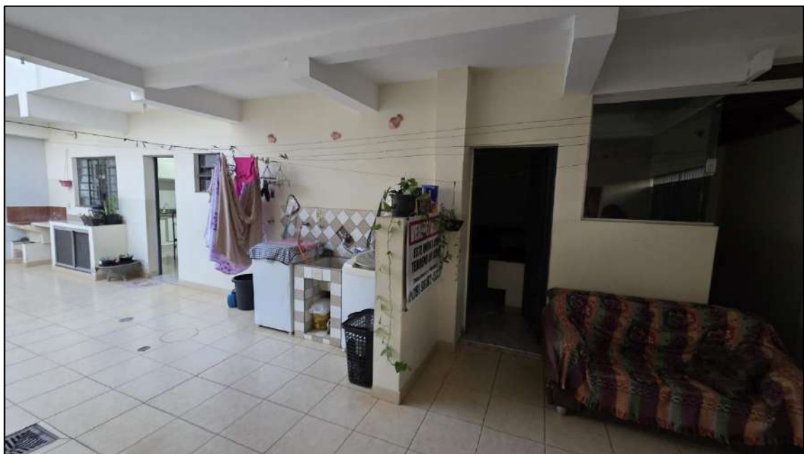
Imagem 11: Vista da garagem para as dependências do imóvel com piso cerâmico, paredes e laje com reboco e pintura.
