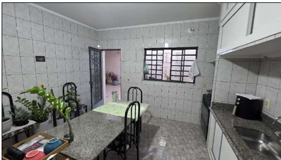
Imagem 18: Cozinha do imóvel com piso e paredes revestidos em cerâmica até o teto, laje com reboco e pintura e acabamento em gesso.
