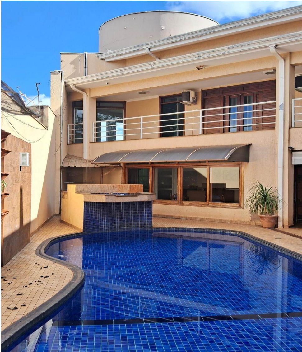
Vista terraço em cima, sala de visita abaixo e piscina.
