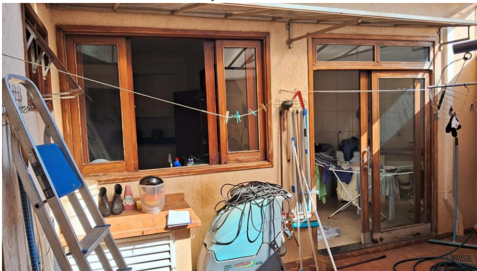
Vista área de serviço e lavanderia.
