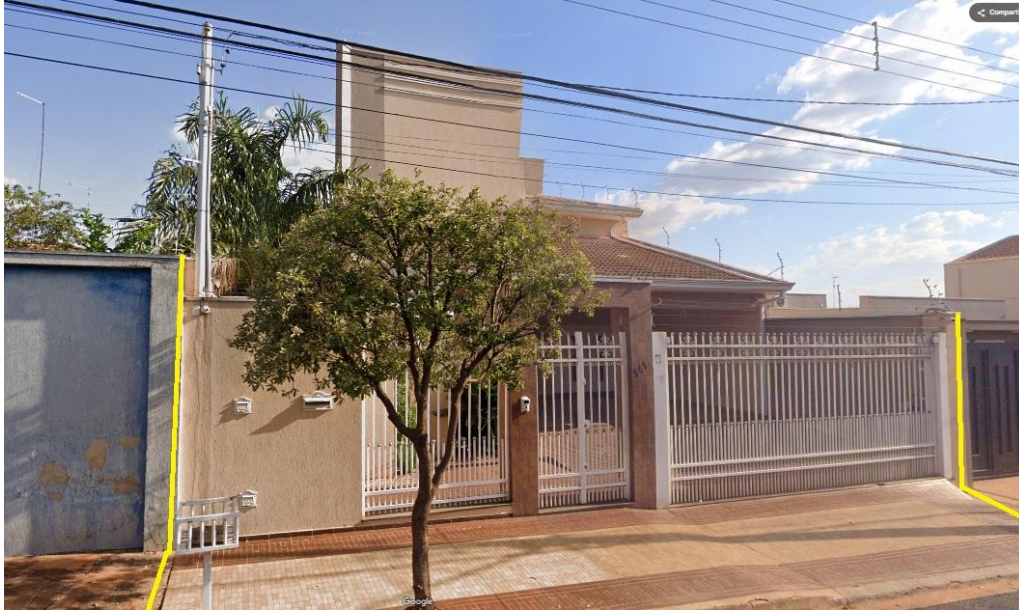
Fachada com vista da garagem e do jardim a esquerda.
