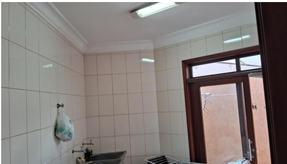
Detalhes acabamento na lavanderia. Sem infiltração e sem manchas e trincos.
