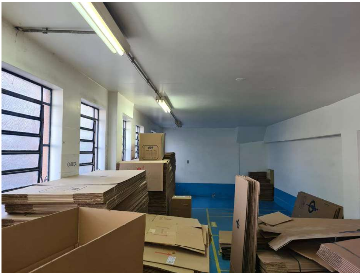
FOTO 12: OUTRA VISTA INTERNA DA ÁREA FABRIL.
