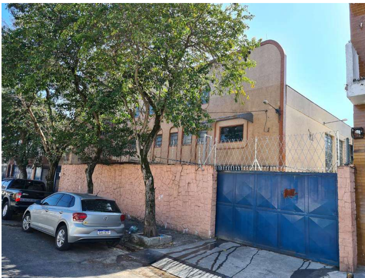
FOTO 6: OUTRA VISTA GERAL DO IMÓVEL AVALIANDO EM QUESTÃO.
