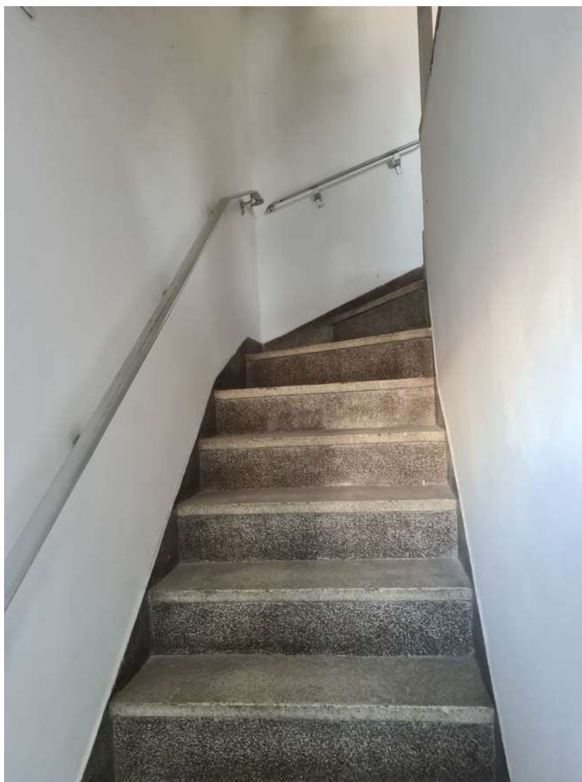
FOTO 22: ESCADA DE ACESSO AO 1º PAVIMENTO.
