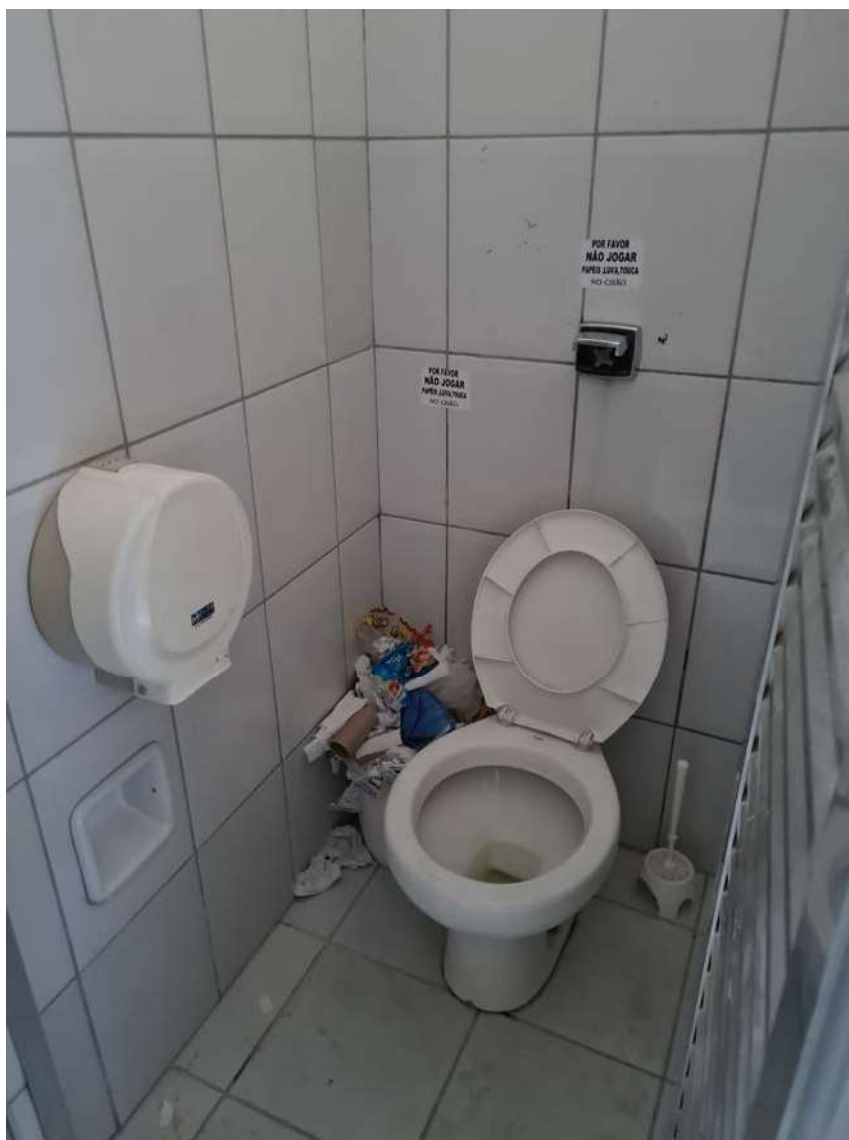
FOTO 17: VISTA DO SANITÁRIO.
