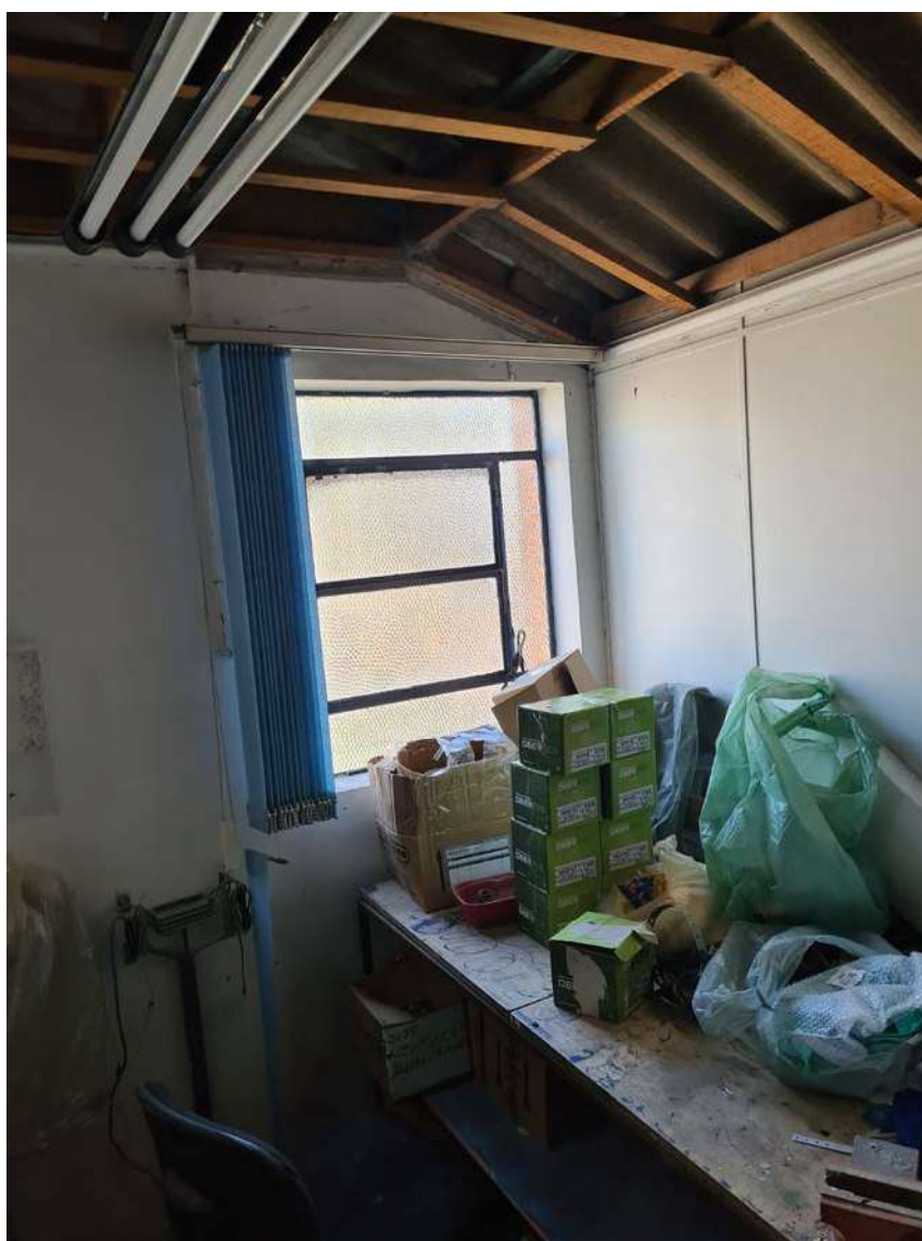
FOTO 28: VISTA PARCIAL DE SALA NO 2º PAVIMENTO.
