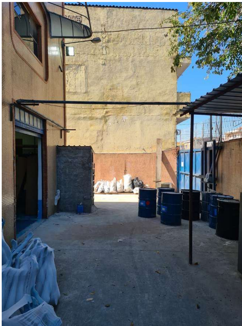
FOTO 9: ÁREA DE CIRCULAÇÃO INTERNA.
