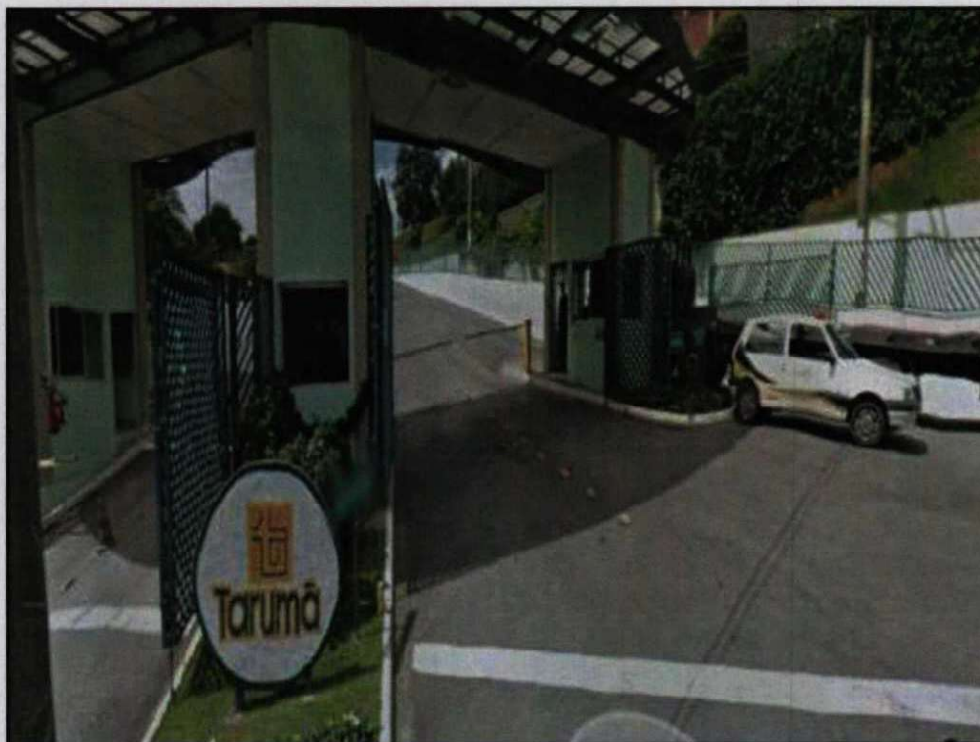
Foto 2 : Entrada do condomínio
