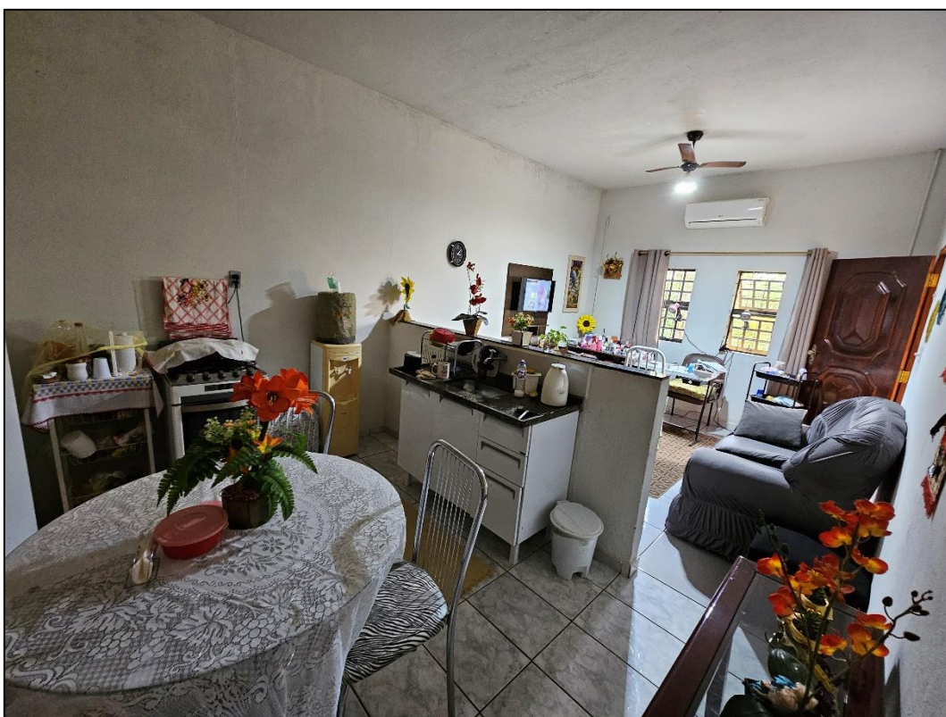
Foto 5 – Cozinha e sala integrada, logo à entrada do imóvel. Piso cerâmico no chão dos ambientes, sem revestimento nas paredes da cozinha, pintura nas paredes e teto (laje) dos ambientes.
