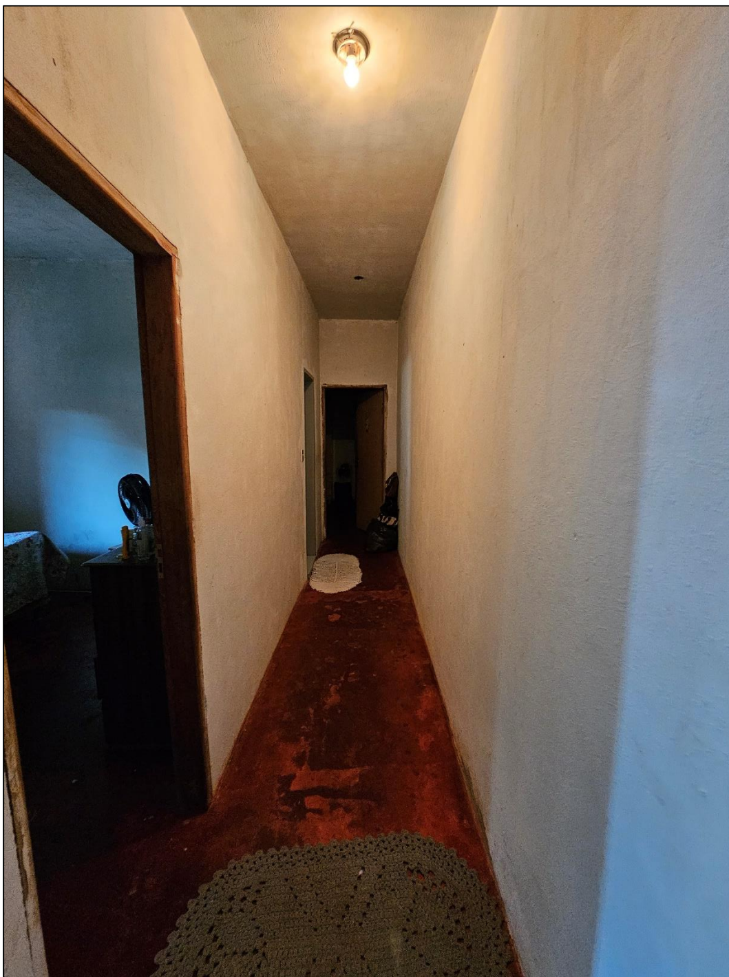
Foto 7 – Corredor de acesso aos dois dormitórios e ao banheiro. Pintura nas paredes e teto (laje) dos ambientes, chão sem revestimentos.
