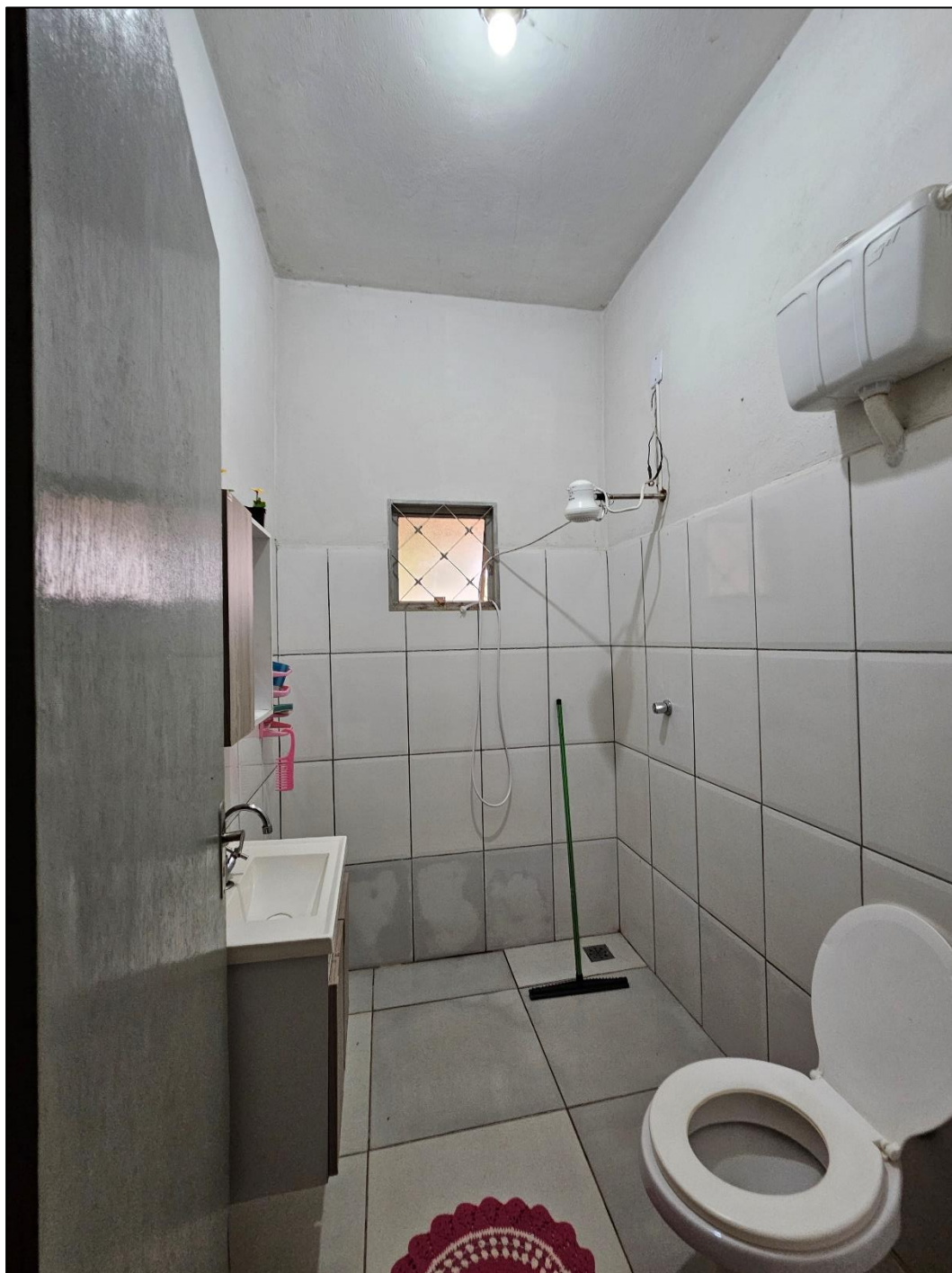
Foto 9 – Banheiro do imóvel. Piso cerâmico no chão e revestimento em meia altura das paredes, restante da parede e teto (laje) com pintura
