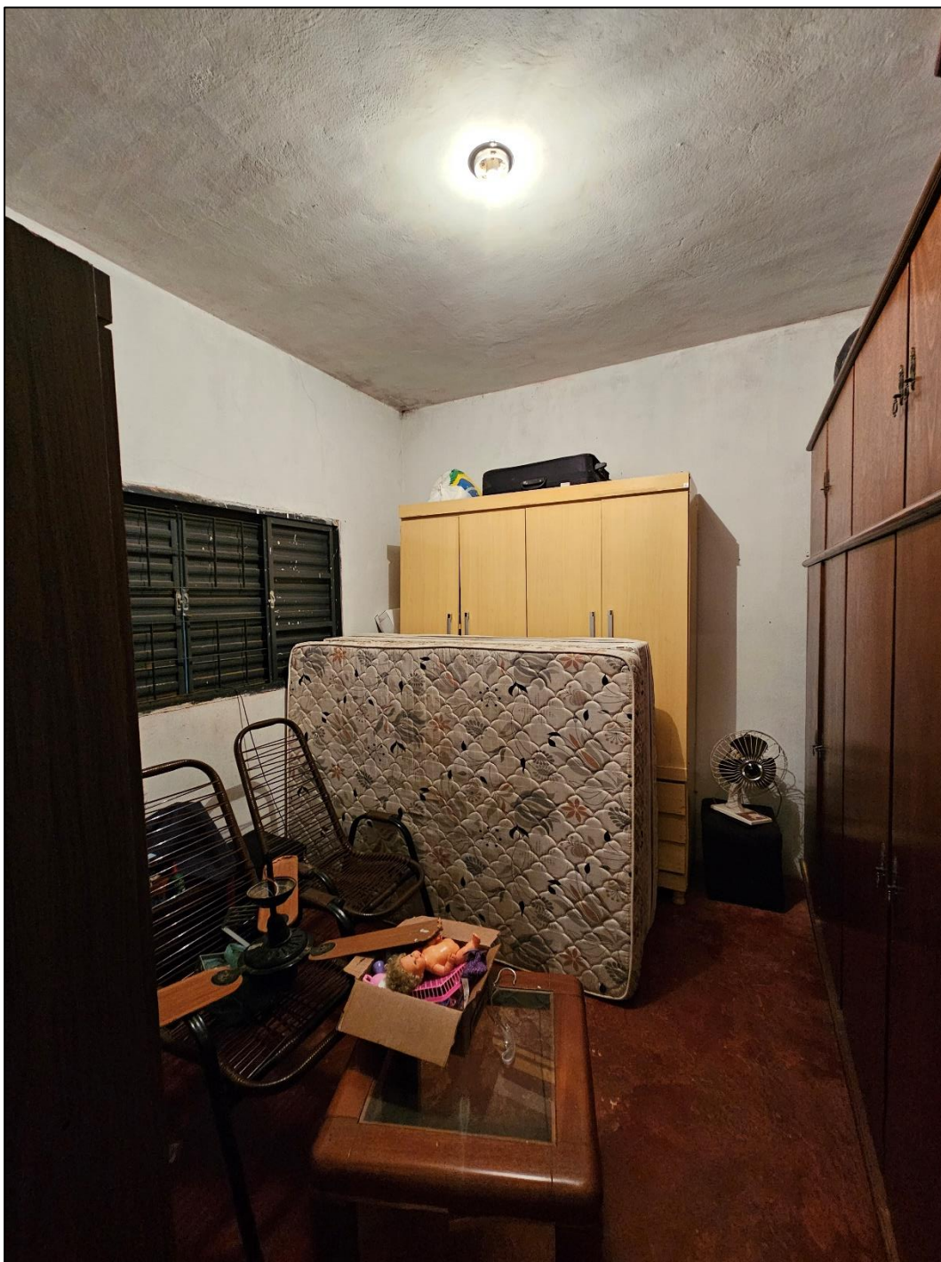
Foto 10 – Quarto aos fundos do corredor. Pintura nas paredes e teto (laje) dos ambientes, chão sem revestimentos.
