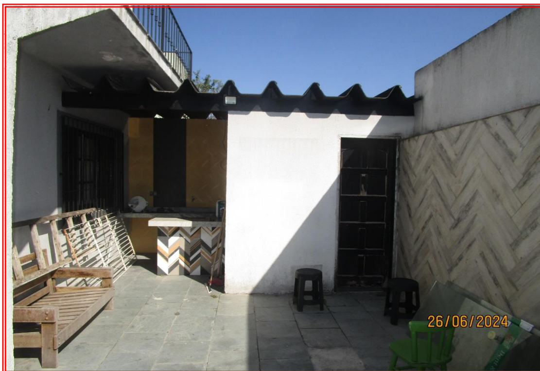
Foto nº 29: Vista geral do quintal descoberto e edícula.
