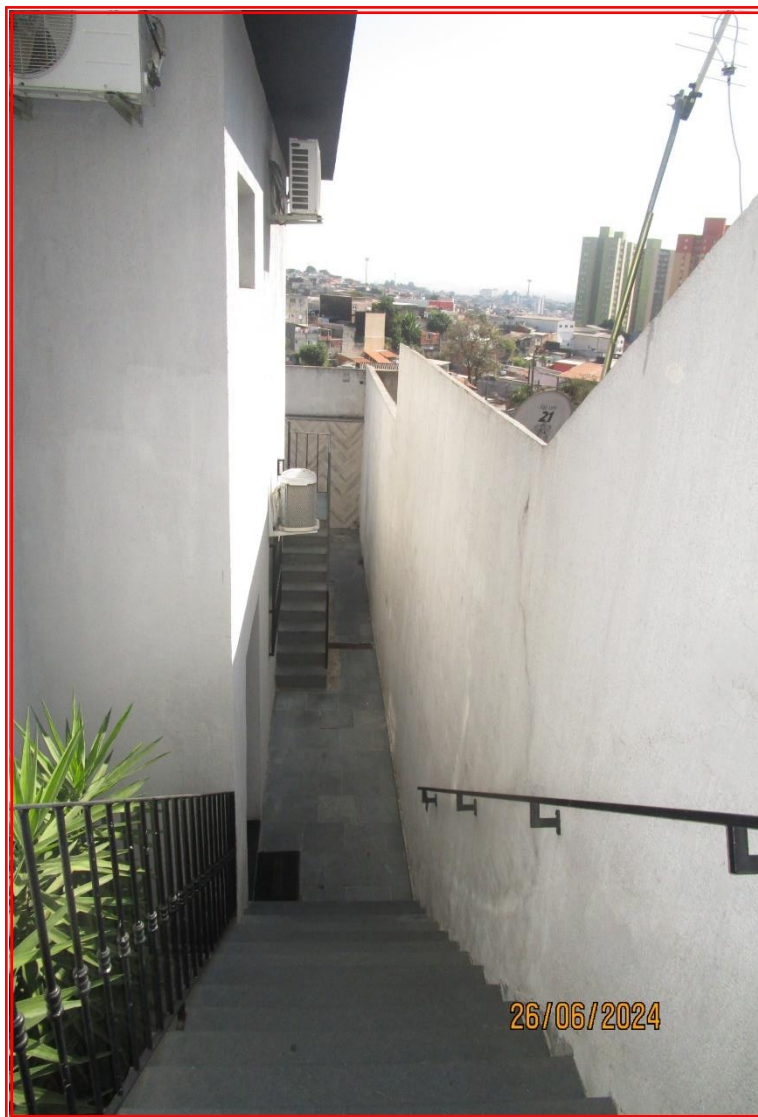
Foto nº 16: Vista geral da escada externa de acesso ao subsolo.
