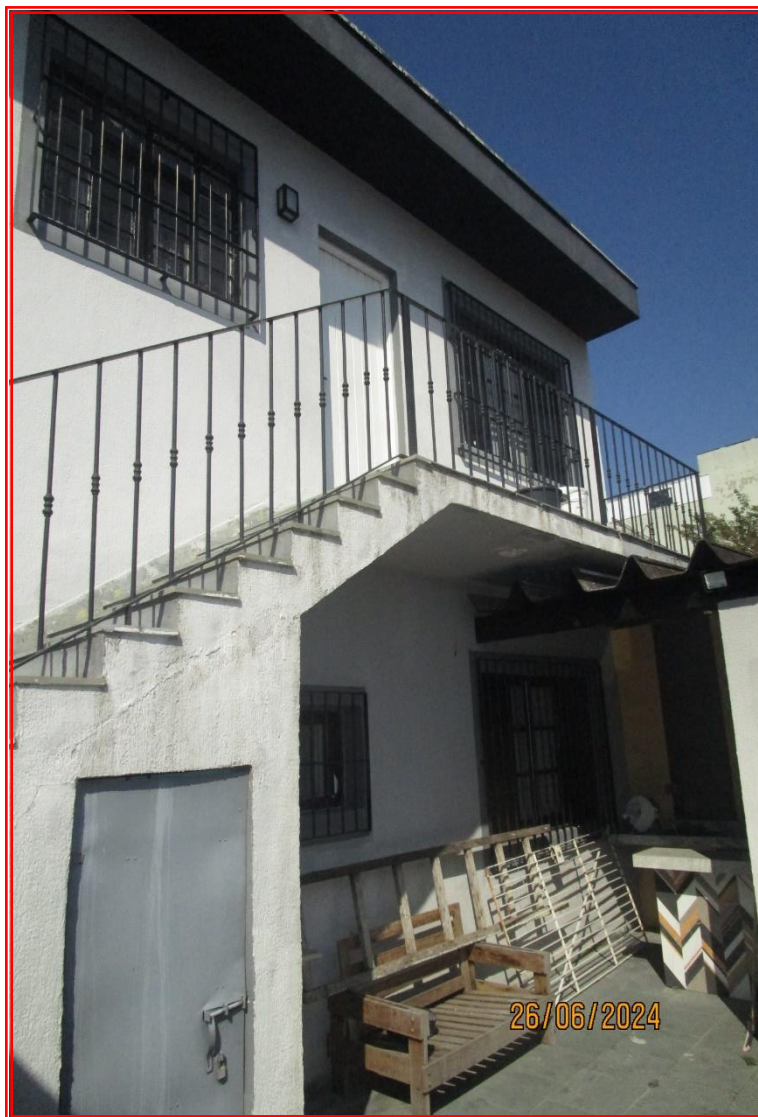
Foto nº 30: Vista parcial de outra escada de circulação entre pavimentos.
