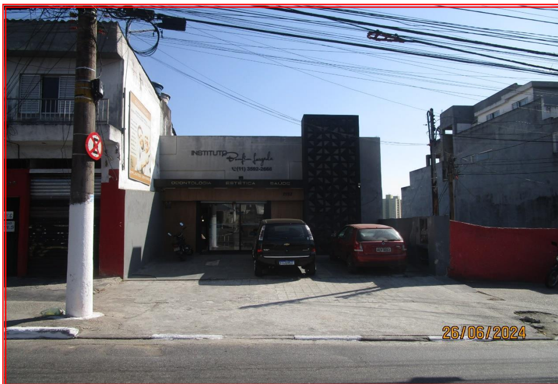
Foto nº 03: Vista geral da fachada do imóvel.
