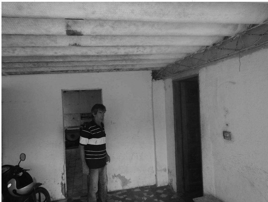
GARAGEM DA CASA 1.
