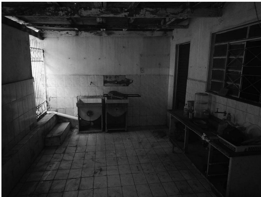
ÁREA DE SERVIÇO DA CASA 1.
