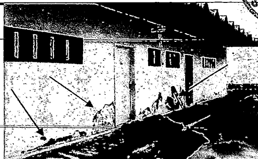
BANHEIRO E VESTIÁRIOS REBOCO DE PAREDE DETERIORADO
