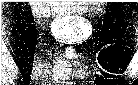
BANHEIRO E VESTIÁRIOS VISTA INTERIOR
