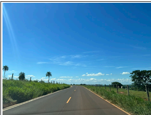
Imagem 01. Vista da vicinal municipal de acesso
